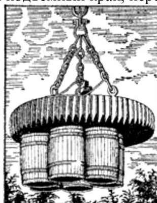
Рисунок 95. Электромагнитный подъемный кран, переносящий бочки с гвоздями.
